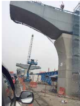
高速道路の2階部分建設中
